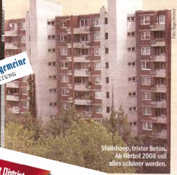
Steilshoop, trister Beton. Ab Herbst 2008 soll alles schöner werden.
