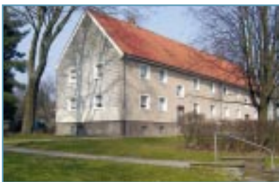
Mehrfamilienhäuser in der Westsiedlung, Salzgitter Bad
