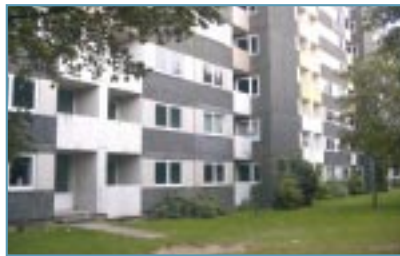
Wohnhochhaus in Lübeck-Buntekuh
