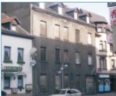
Leerstehendes Wohngebäude in der Innenstadt
