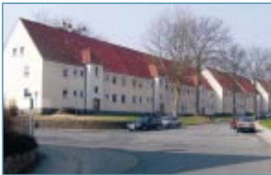
Mehrfamilienhäuser in der Westsiedlung, Salzgitter Bad
