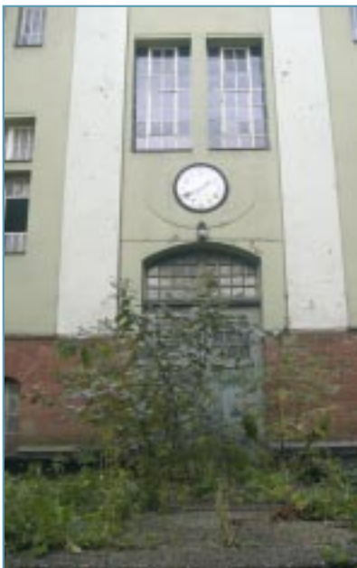
Detailansicht des Industriekomplexes Rheinberger
