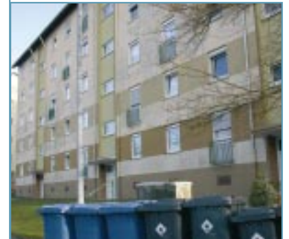
Wohngebäude Auf der Hahnenruh
