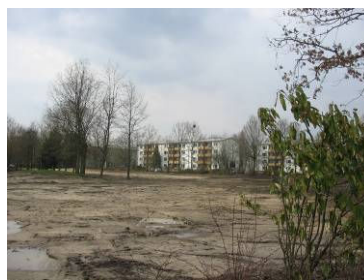
Fläche nach dem Abriss
